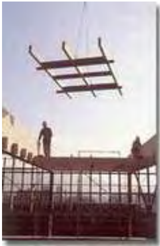
Montaje del entramado .
