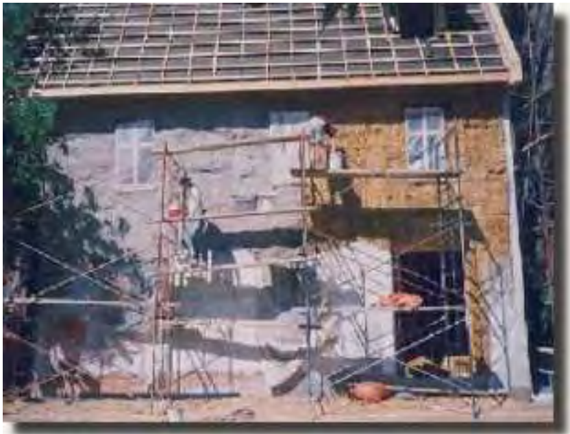
Revestimiento de muros con estuco
