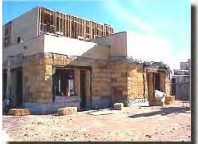
Uso de fardos como cerramiento
