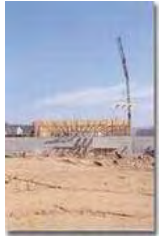
Montaje de la estructura.
