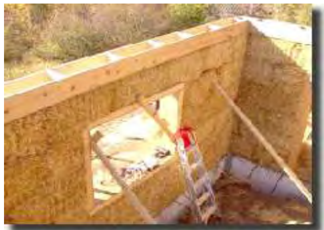
Utilización de fardos como estructura
