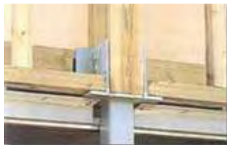
Encuentro entre el pilar de madera y la columna metálica.
