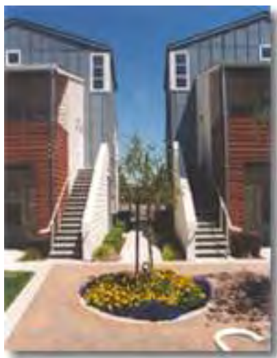
1. Vista desde el patio interno a la entrada principal.
