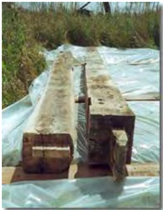
Después del desmontaje, las maderas pesadas se catalogaron, se fumigaron, se enarenaron y se terminaron con barniz poliuretánico.
