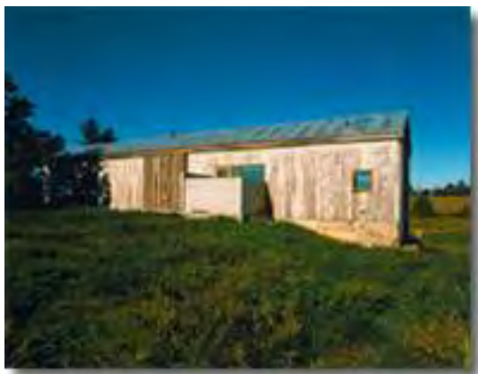
Otra vista sur con la puerta deslizable de hórreo cerrada. Observar las paredes de concreto que circundan la ducha externa.
