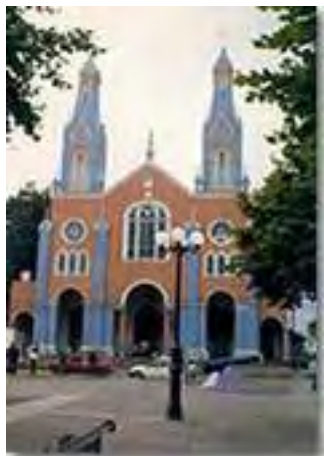
Iglesia de Castro – Isla de Chiloé. Estructura y cerramientos en madera con terminación exterior en chapa estampada y pintado de vivos colores.
