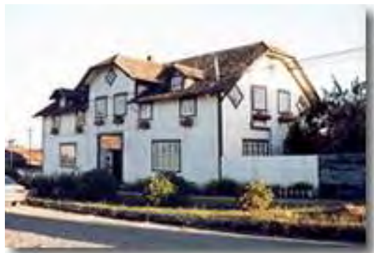
Casa Originaria – Puerto Varas. Tejuela de alerce pintada en muros. Cubiertas a dos aguas con el extremo superior chanfleado.
