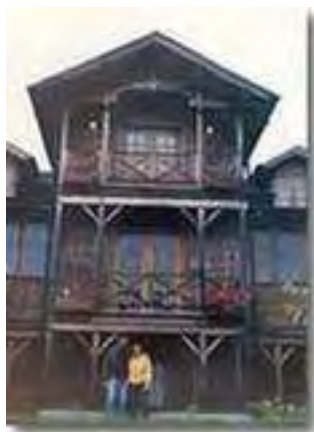
Casas de segunda y tercera generación de colonos alemanes - Frutillar. Totalmente en madera, esta casa reconstruida manifiesta un esmerado trabajo del “maestro carpintero” y los artesanos chilenos.
