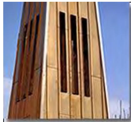
El detalle de la cubierta de cobre de la aguja.
