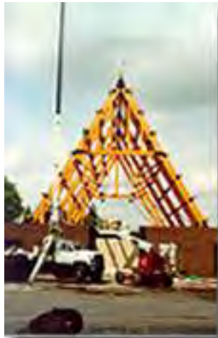
La estructura, de madera laminada encolada, durante la construcción.
