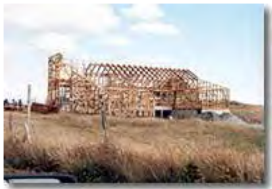
Vivienda actual en construcción – Puerto Varas
