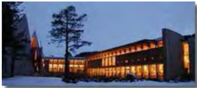
El edificio Sámediggi, con el vestíbulo de la asamblea a la izquierda.
