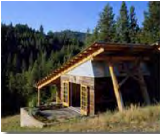
La vista norte muestra la columna y la viga de troncos descargando en la pared. Las puertas abren desde el dormitorio a la terraza
