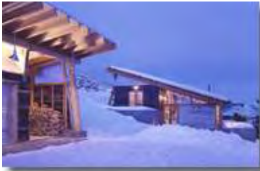
La viga de madera de la cubierta del garaje con la cabaña detrás.
