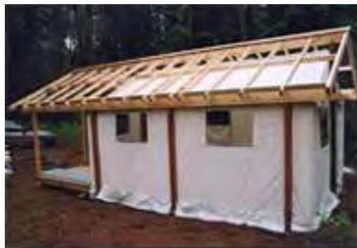
La instalación de la carpa se suspende desde la estructura de madera.
