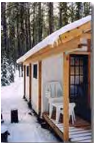
El techo alquitranado con los paneles de PVC ayudan al desplazamiento de la nieve hacia afuera.
