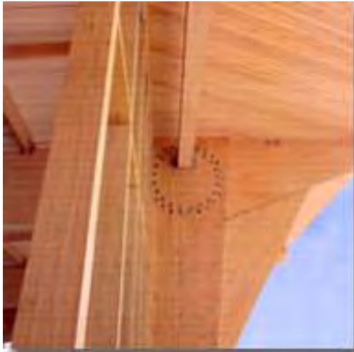
Edificio Centromaderas. Arqtos. José Cruz y Juan Purcell
