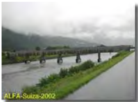
Rheinbrücke. Vaduz. Suiza-Lichtenstein. 1866. Tiene dos tramos de 26.6m y cuatro tramos de 20.35m con un largo total 135.40m. Se declaró monumento nacional. En la actualidad se lo utiliza para peatones y ciclistas. Es una viga Howe compuesta de diagonales entrecruzadas y tensores verticales de acero. Tiene 6 tramos sobre 5 pilotes que soportan cargas de viento y la fuerte corriente del río.
