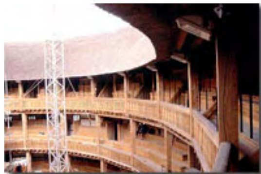
Vista de las galerías del auditorio.
