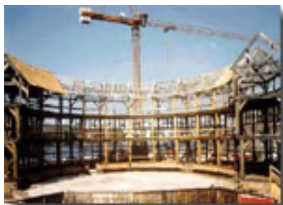
Construcción de la estructura - el río Támesis detrás.
