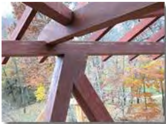
2. Detalle de la estructura.
