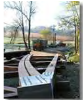
4. Montaje de una de las vigas.
