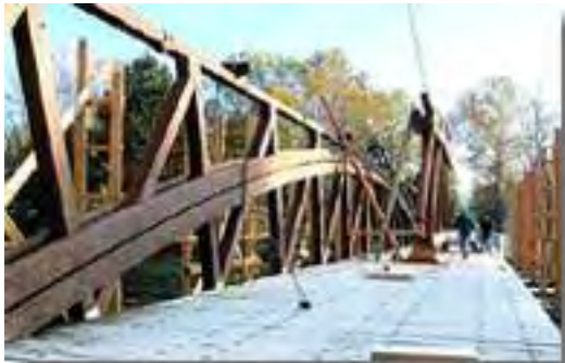
6. Vista interior del montaje.
