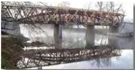
5. Vista general del montaje del puente.
