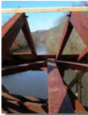
3. Detalle de la estructura de la cubierta.
