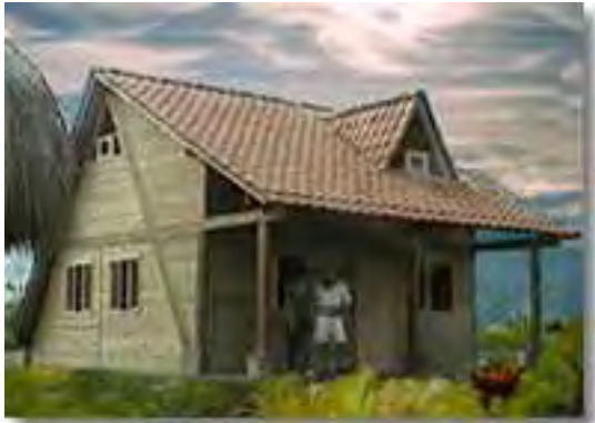
Vivienda de Campo. Construida por: C. I. Maderinsa S. A. Ingeniería de la Madera. Medellín Antioquia. Archivo fotográfico Maderinsa S. A.
