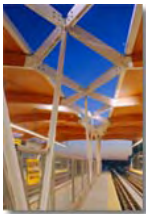
Detalle del encasetonado metálico y los tensores
