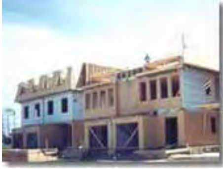
Construcción de viviendas en madera en Canadá.
