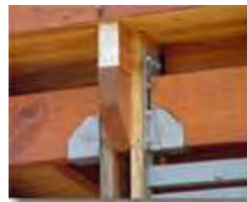
Encuentro columna principal con una viga.
