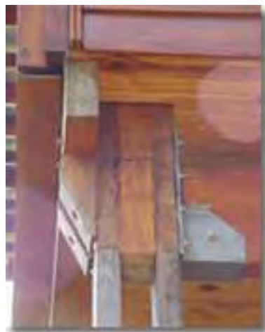
Encuentro de una columna principal con una viga.
