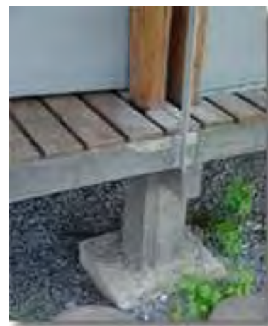
Unión entre una columna principal con fundación en hormigón armado
